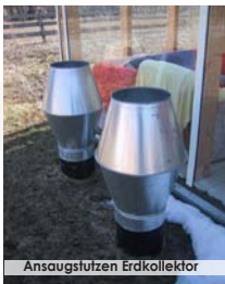
Ansaugstutzen Erdkollektor
