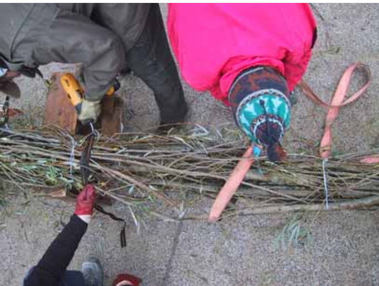
Abbildungen 40-42: Binden der Faschinen
