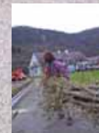
Abbildungen 43-48: Faschinentransport
