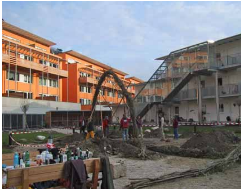
Abbildungen 49-51: Der erste Bogen - Errichtung und Fixierung mit Holzstangen
